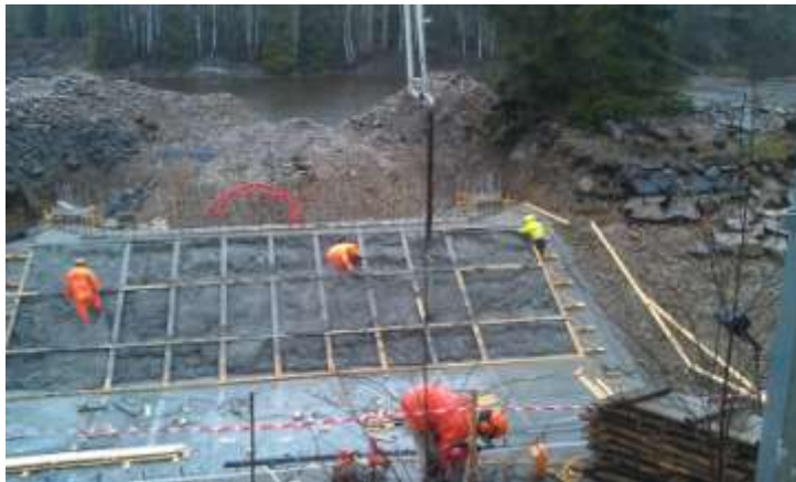
Magring av byggegrua
