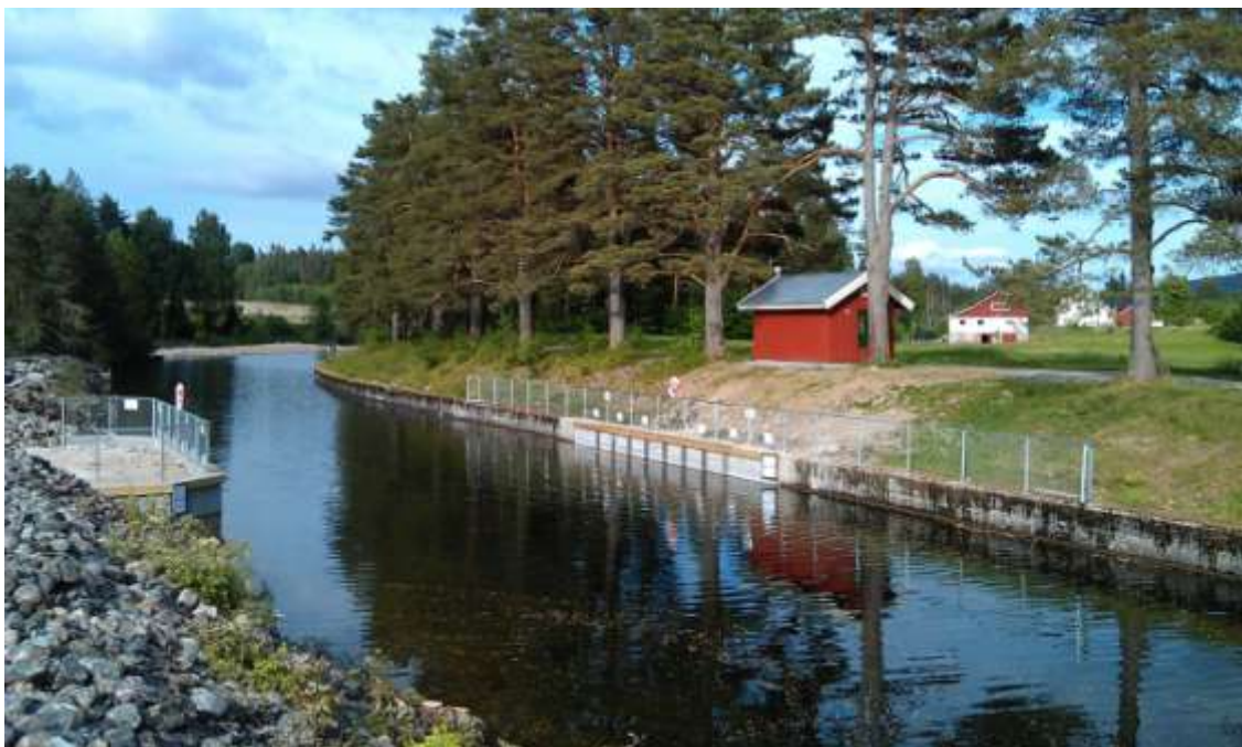
Elektrisk fiskesperre, Kjeldal, etter oppstart
