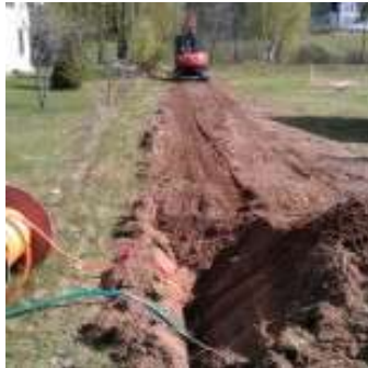
Strøm og fibertrekkerør ble gravd ned.
