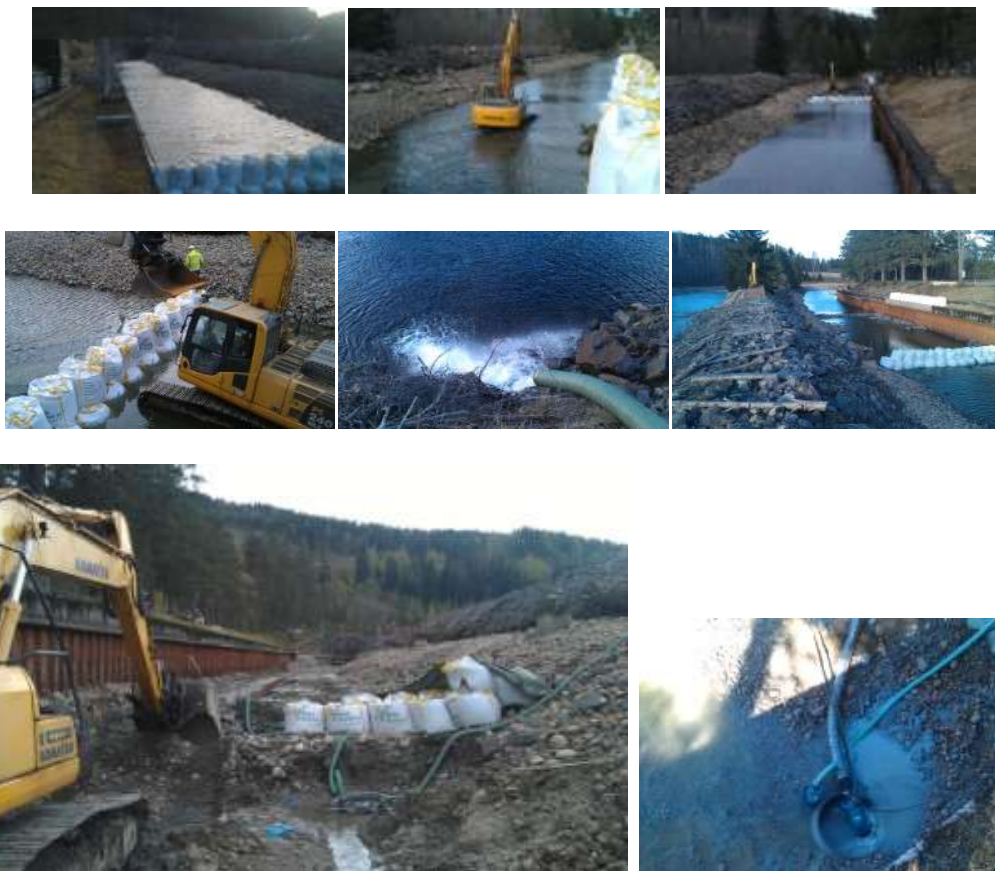
Først måtte kanalen tørrlegges, og midlertidige fangdammer etableres. Sandsekker, presenninger og pumper ble benyttet i bygge perioden.
