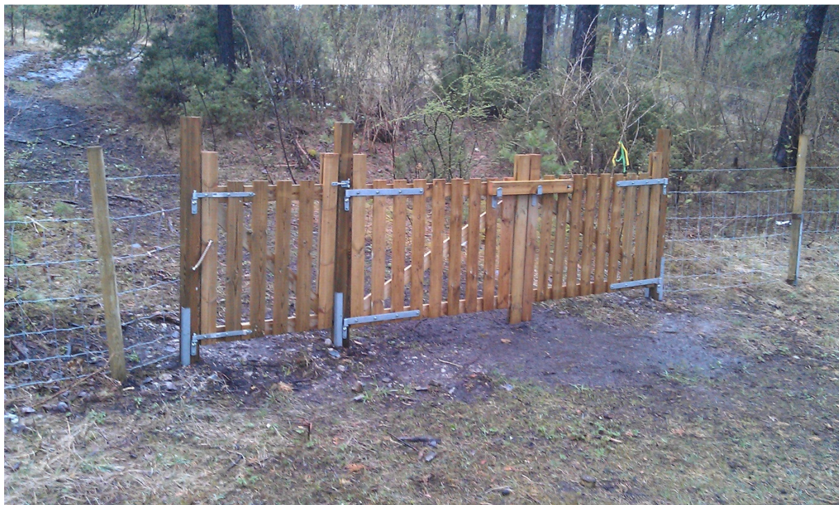
Bilde: Dobbel grind m/Port nr 11 – ved tennisbanen
