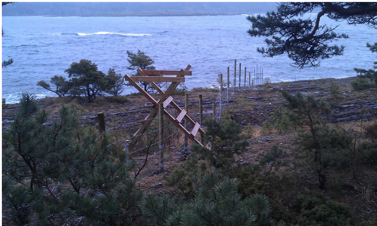
Bilde: Gjerdeklyv nr: 3 – solid feste på begge sider med fjellbolter
