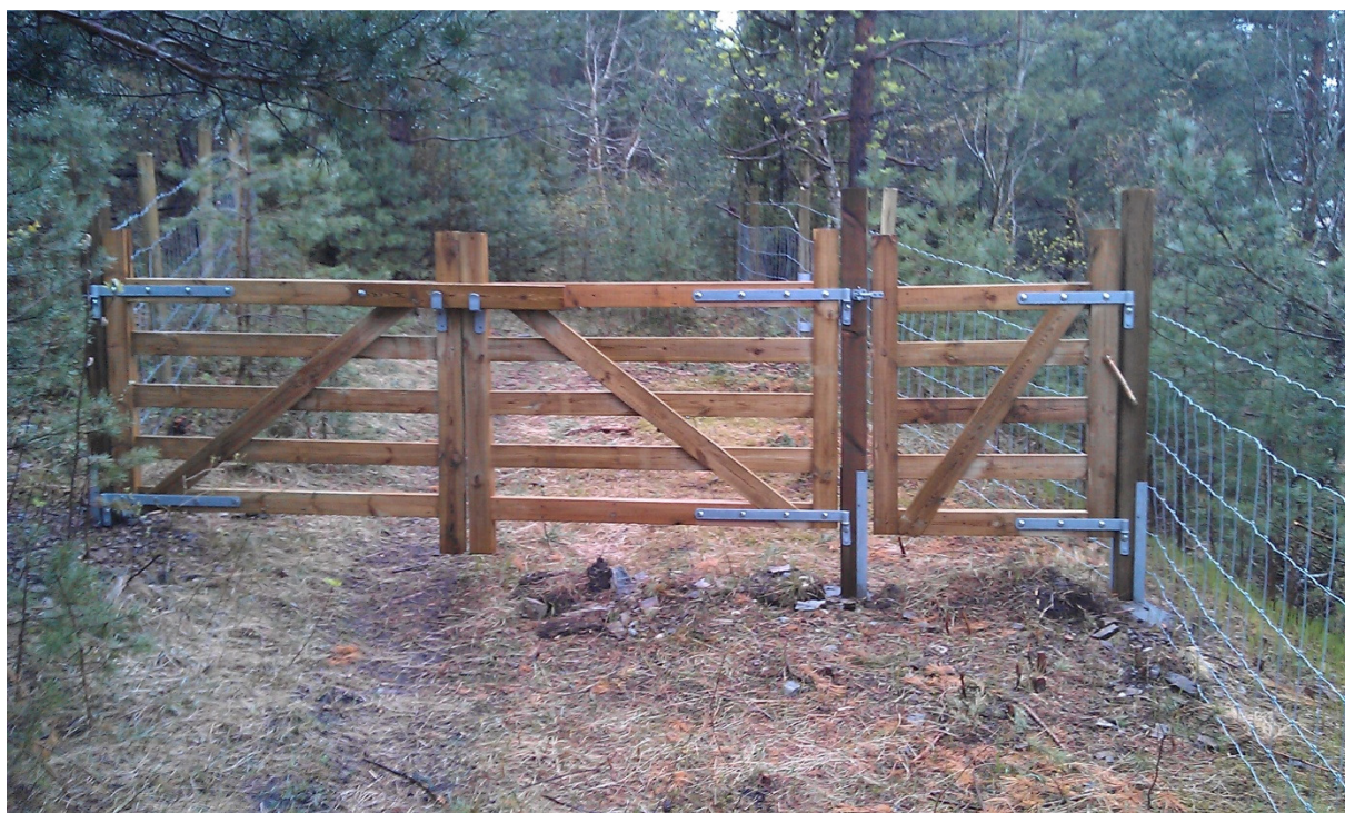
Bilde: Dobbel grind m/Port nr:2 – solide hengsler, vinkeljern i betongfundament og lukkefjær.
