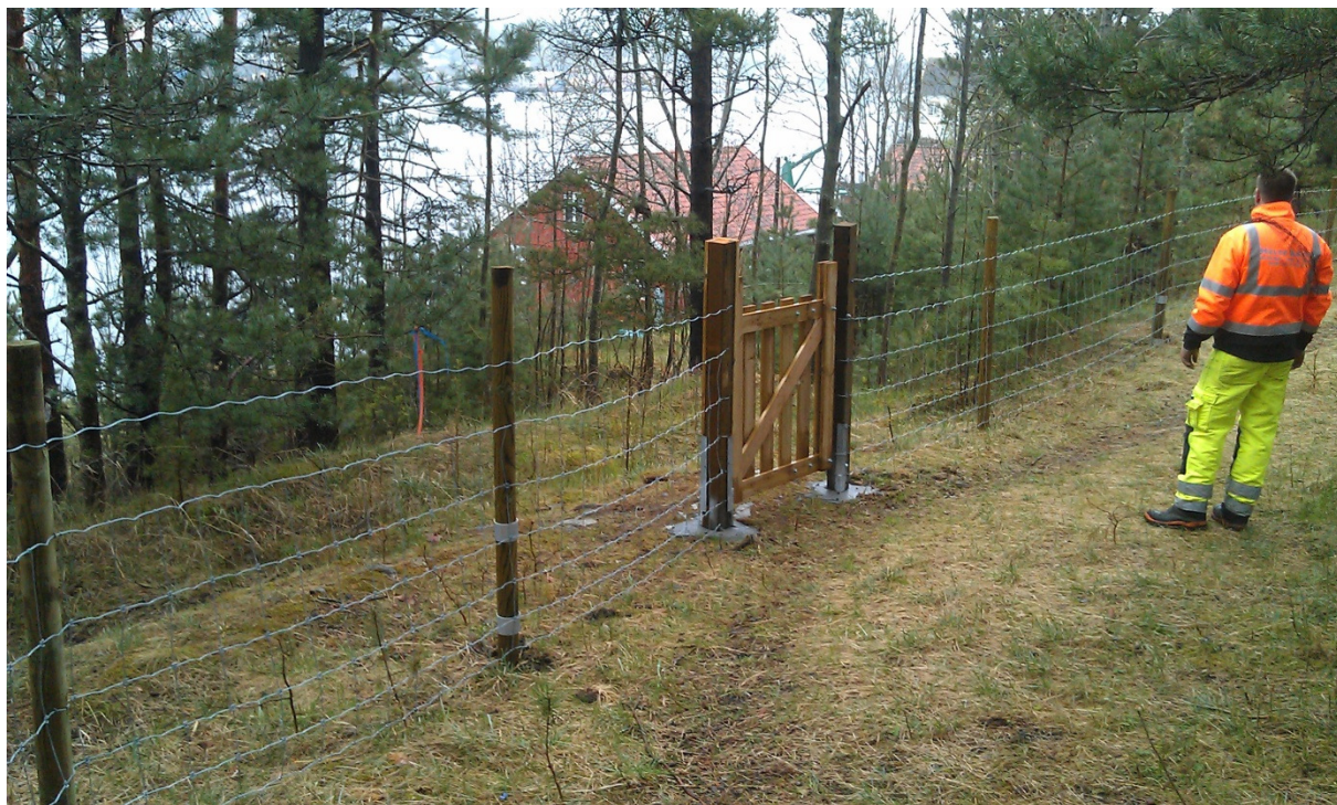
Bilde: Enkel port opp for bryggeanlegget nr: 6
