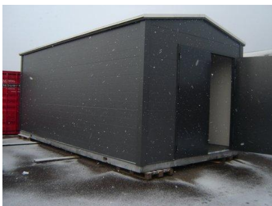
Bilde 5.1: Eks på prefabrikkert pelletssentral
