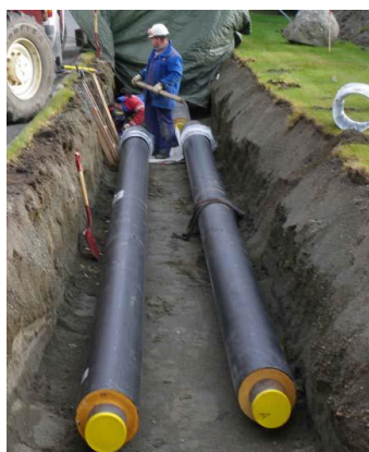
Bilde 3.1 Eksempel på rørgate i stål
