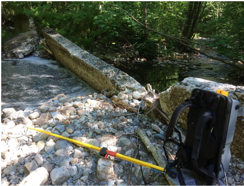
Bilde: Den gamle dammen som delvis har kollapset har hatt revner som nå er tettet igjen med sammenpakkede steinmasser.
