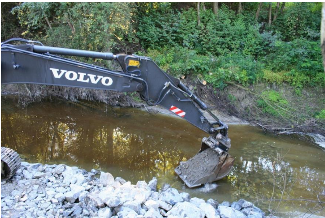
Bilde 3.4: Arbeidet med stabilisering pågår, oppbygd liten terskel vises i nedre høyere bildekant
