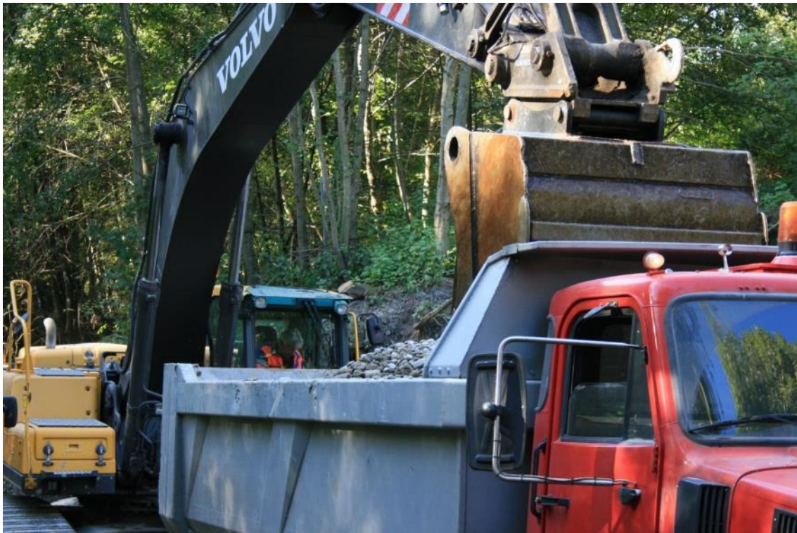
Bilde 3.5: Første lass med gytegrus ankommer, denne ble tatt rett fra bilen for å ikke sammenblande den med andre masser
