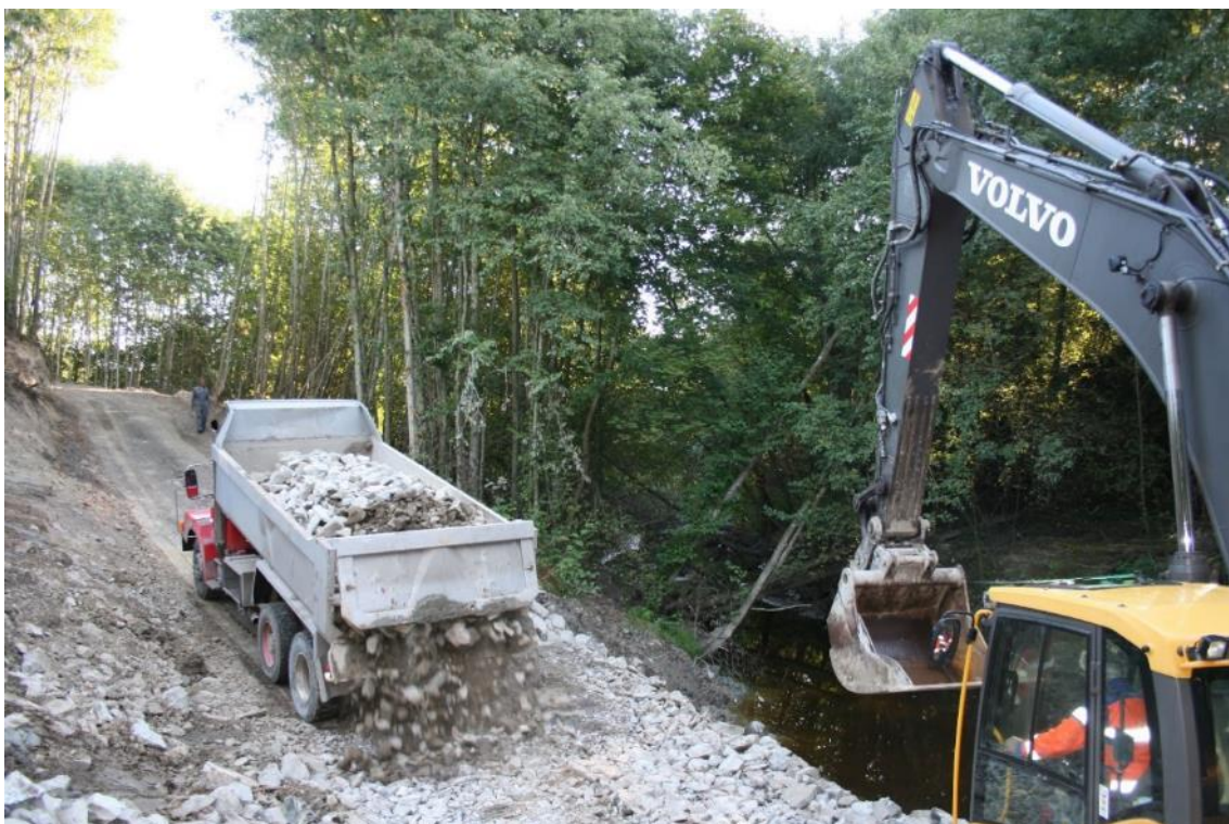
Bilde 3.2: Første lass av grovknust masse ankommer for stabilisering av ustabilt finpartiklet bunnsstrat
