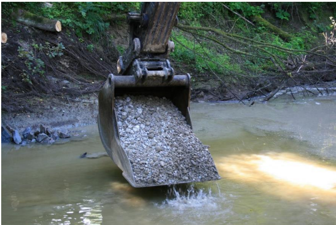
Bilde 3.6: Gytegrusen ble lagt ut «skuffe for skuffe»
