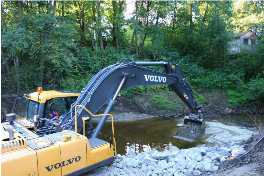
Bilde 2.3: Under arbeidet ble det benyttet en 29 tonns beltegraver
