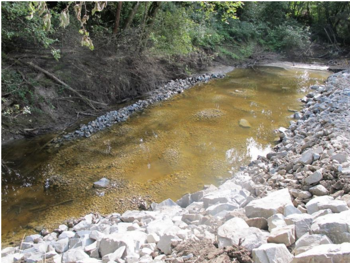
Bilde 3.9: Utlagt gytegrus på sone 1 etter endt tiltak. For å bryte opp området ble det i tillegg lagt ut noen større steiner
