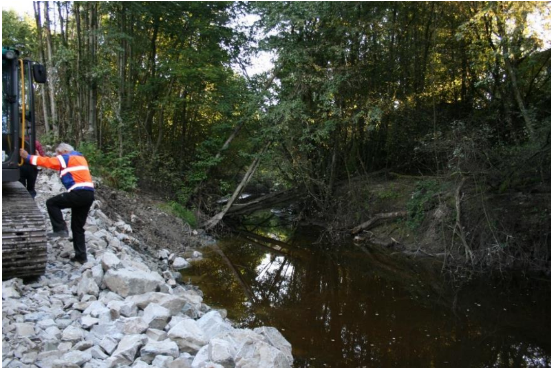
Bilde 3.1: Arbeidet på sone 1 tar til, kommunens anleggsvei og skredsikringsarbeid er ferdig
