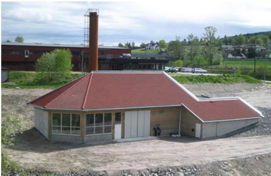
Bilde av varmesentralen ved Bø Fjernvarme AS
