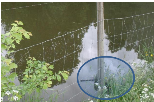
Bilde: Bildet av overløpet i dammen
