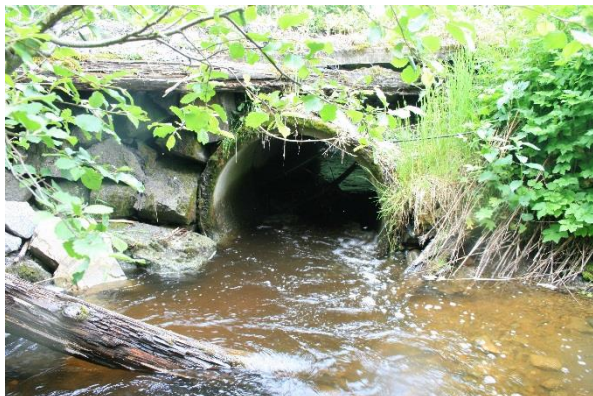
Bilde: Rør under traktorvei ligger dypt og bra i veikroppen og er uproblematisk.
