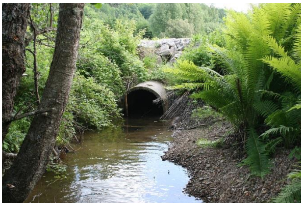
Bilde: Den lille sidebekken var preget mye godt egnet substrat, kulvert under jordet sees i bakkant.
