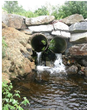
Bilde: Bildet viser de to rørene under traktorveien. Det danner seg et markant vertikalt sprang med unntak av ved storflom
