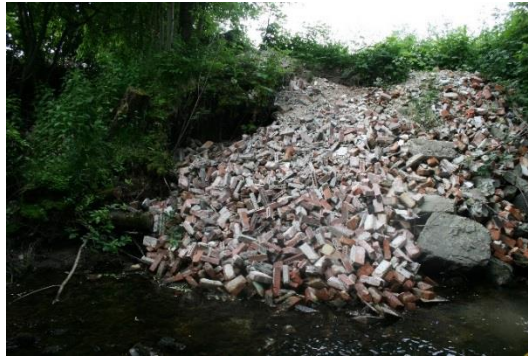
Bilde: Passasje ved øvre dam er problematisk
