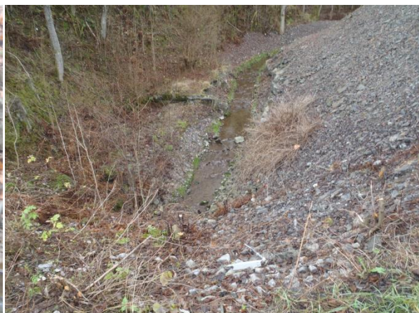
Bilde: Steinsatt og modellert bekkeløp
