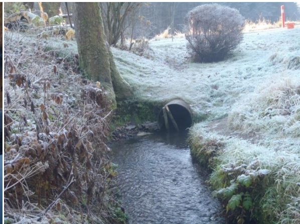
Bilde: Rør under jorde sett fra oppstrøms side
