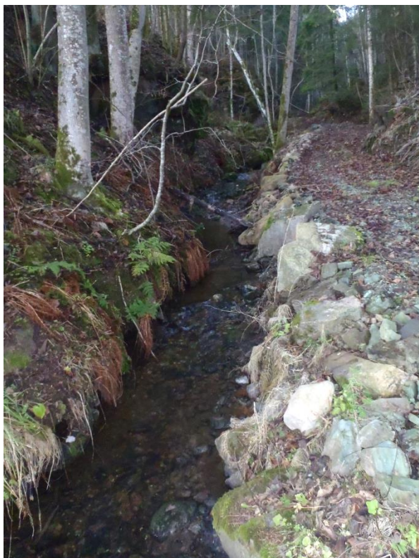
Bilde: Parti fra bekken oppstrøms gjenrast kulvert
