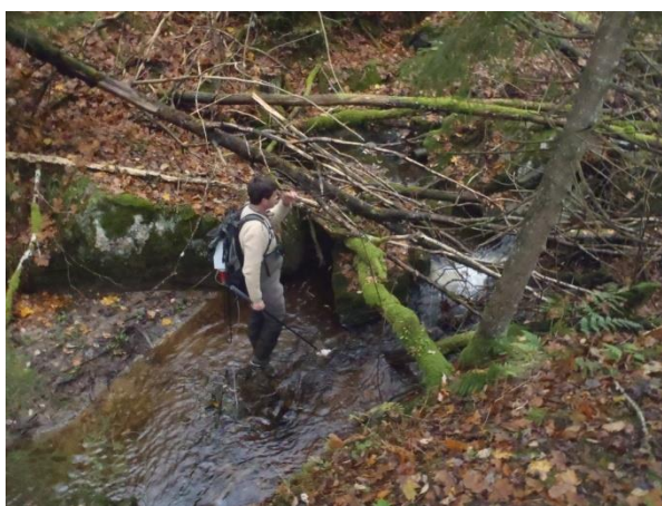
Bilde: Eksempel der rydding kan utføres
