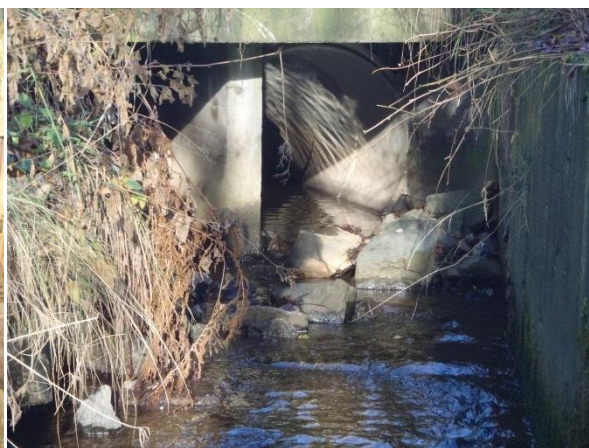
Bilde: Kryssning av veier sett fra nedstrøm side
