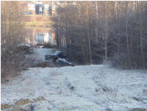
Bilde: Bekken lagt i rør, opprinnelig løp trolig i venstre billedkant
