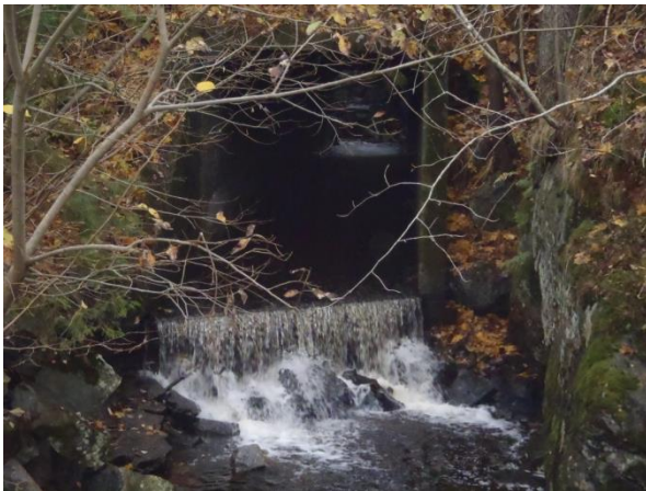
Bilde: Oppgangshinder 1, betongkulvert
