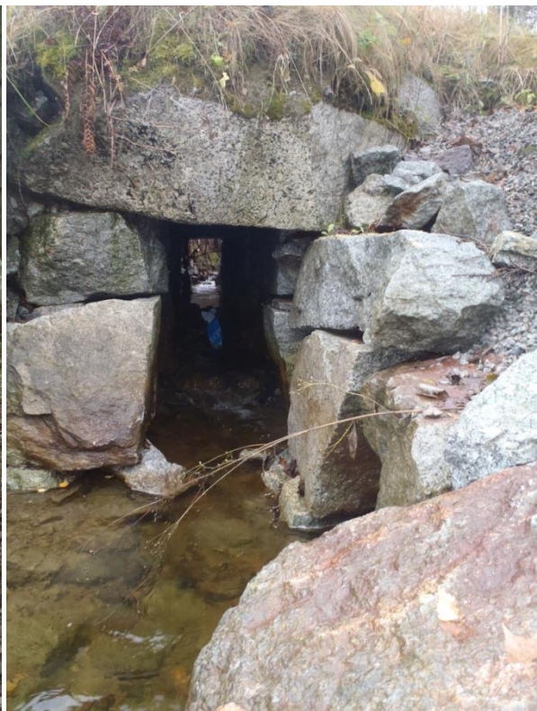
Bilde: Steinsatt kulvert under bilvei, uproblematisk
