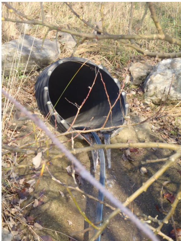
Bilde: Utløp av rør under riksveg 353 høyt i steinfyllingen
