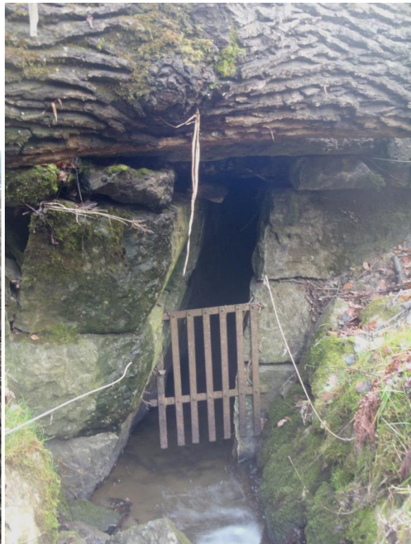
Bilde: Krysning under jernbane, sett fra oppstrøms side
