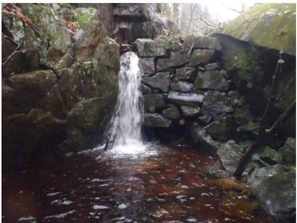
Bilde: Oppgangshinder 2, eldre dam
